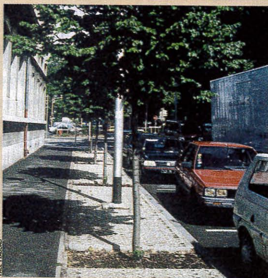
LES DALLES EN BÉTON préfabriqué sont installées sur des longrines pour éviter qu'elles ne reposent directement sur la bande plantée.
