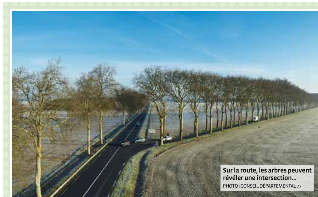
Aménagées, les sections d'approche fonctionnent sur le même principe : modification visuelle de la chaussée par la mise en place d'une bande claire (jaune ou blanche) au centre et d'un enduit en porphyre rouge de part et d'autre, associé à la plantation d'arbres ou de haies. Ci-contre, à gauche, un accotement suffisamment large a permis d'intégrer un cheminement piéton derrière la plantation.
