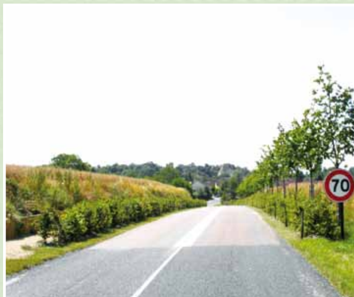
Aménagées, les sections d'approche fonctionnent sur le même principe : modification visuelle de la chaussée par la mise en place d'une bande claire (jaune ou blanche) au centre et d'un enduit en porphyre rouge de part et d'autre, associé à la plantation d'arbres ou de haies. Ci-contre, à gauche, un accotement suffisamment large a permis d'intégrer un cheminement piéton derrière la plantation.
