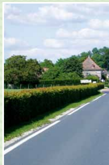
Aménagées, les sections d'approche fonctionnent sur le même principe : modification visuelle de la chaussée par la mise en place d'une bande claire (jaune ou blanche) au centre et d'un enduit en porphyre rouge de part et d'autre, associé à la plantation d'arbres ou de haies. Ci-contre, à gauche, un accotement suffisamment large a permis d'intégrer un cheminement piéton derrière la plantation.
