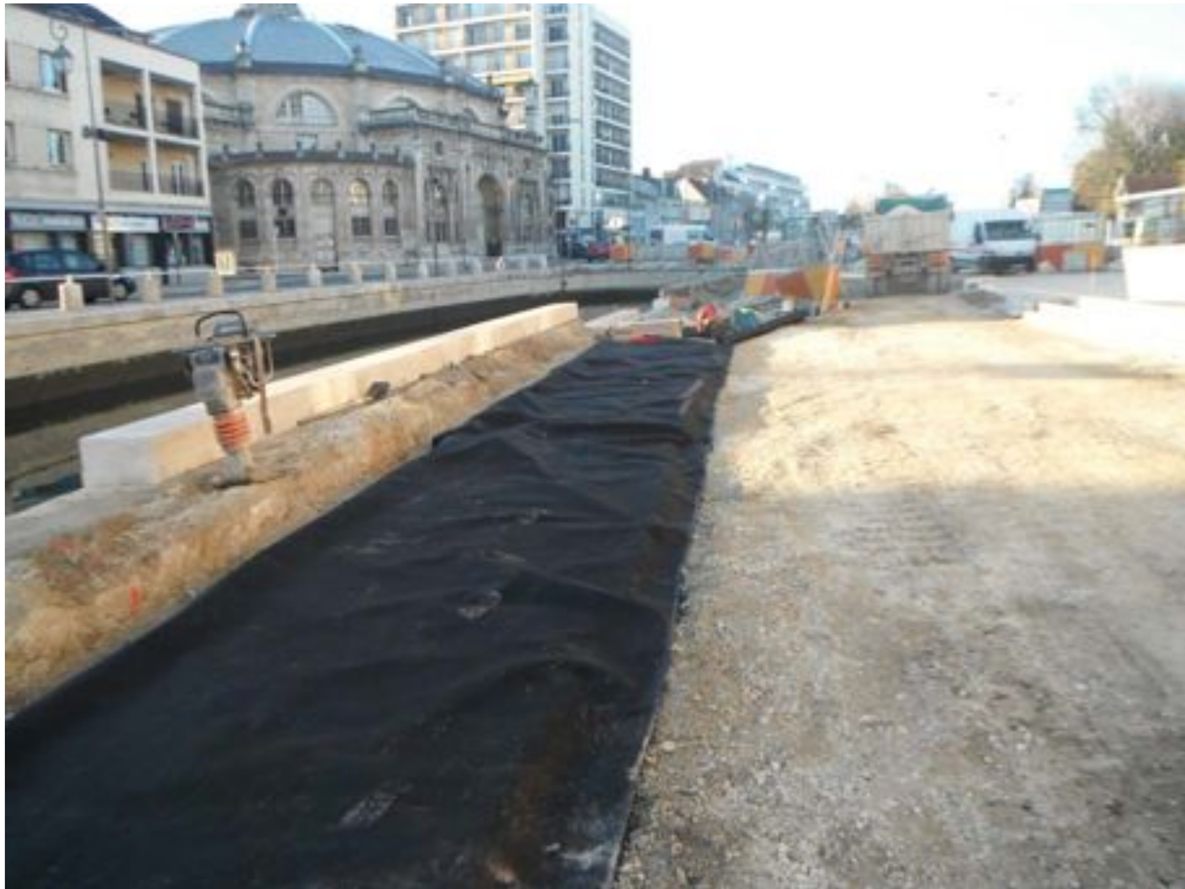
Mise en place du géotextile
