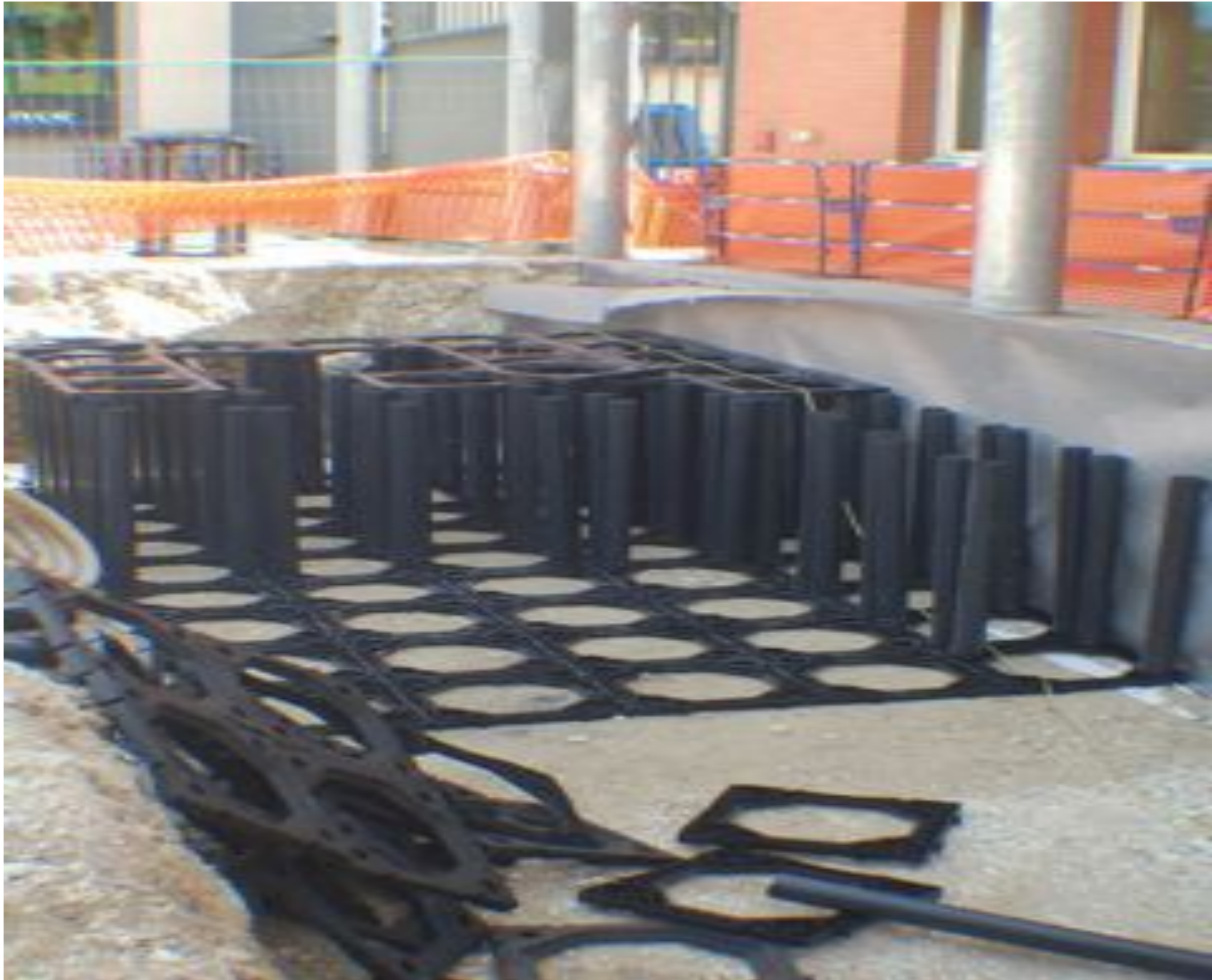
Pose des structures et anti racine
