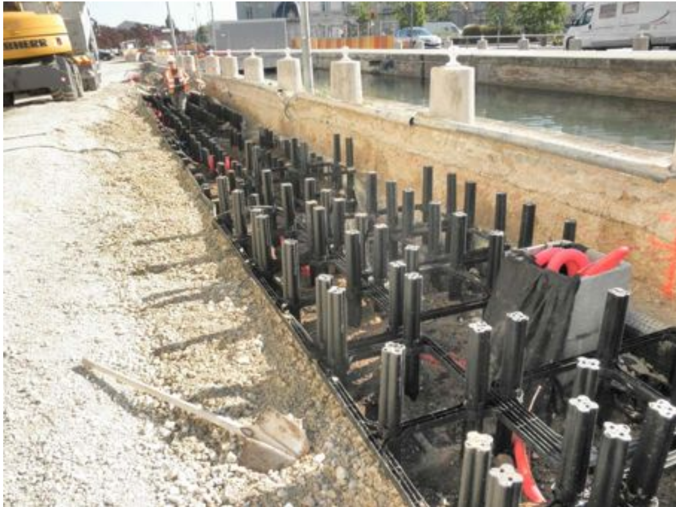
Structure en phase final
