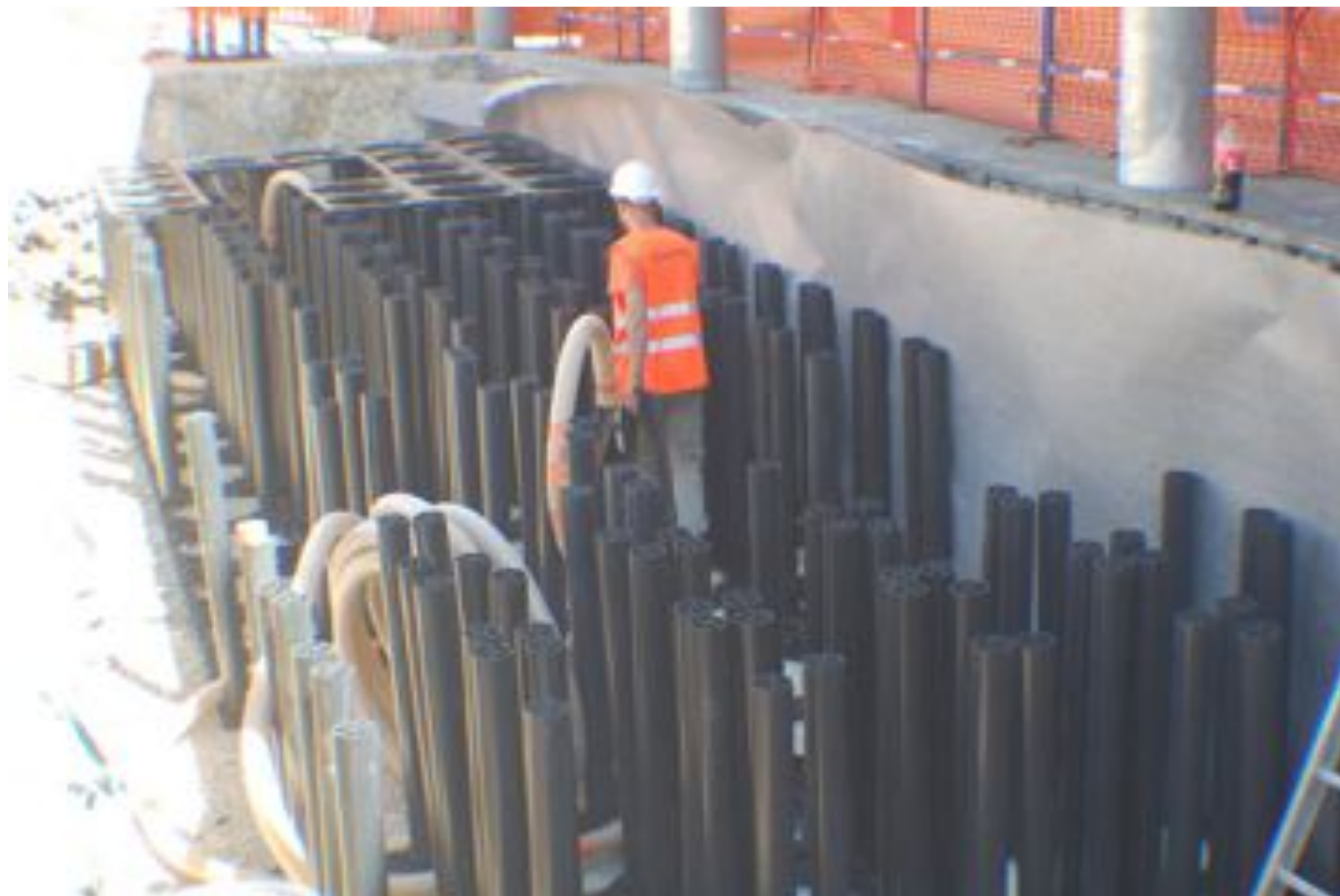
Pose de la géogridde et de l'Air Max
