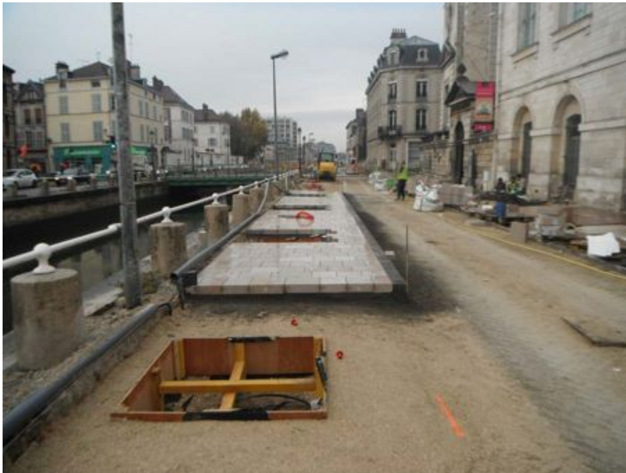
Revêtement définitif en cours de pose
